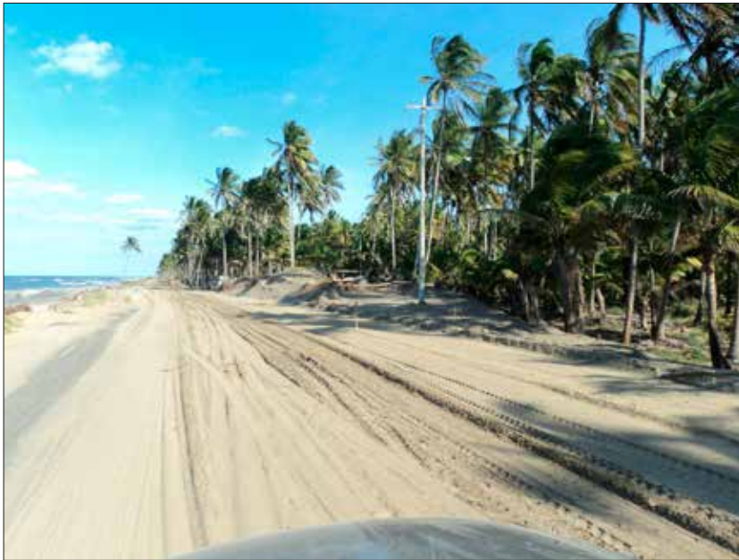
Figura 2. Construcción de carreteras en costa tabasqueña, México. Foto: Rodimiro Ramos Reyes.
